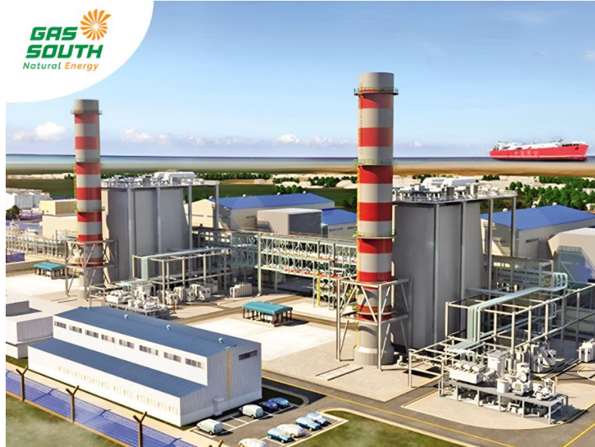
Dự án LNG Bạc Liêu
